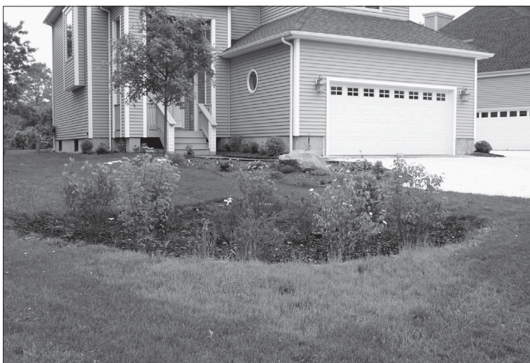
Figur 3. Regnbed er et blomsterbed med arter som liker høy fuktighet. Bedet lages slik at vannet infiltrerer jorda i løpet av 24 timer. Dermed unngås problem med mygg (mer om rain gardens finnes på internett).
