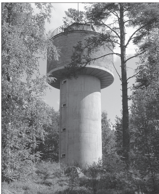
Figur 2. Betongen blev dominerande. Vattentornet i Bollnäs byggt 1946 och taget ur drift 1969. Volym cirka 350 m 3 . Anpassat för östra Bollnäs-Ren, med en befolkning på ungefär 1000 invånare. Foto: Kenneth M Persson.
