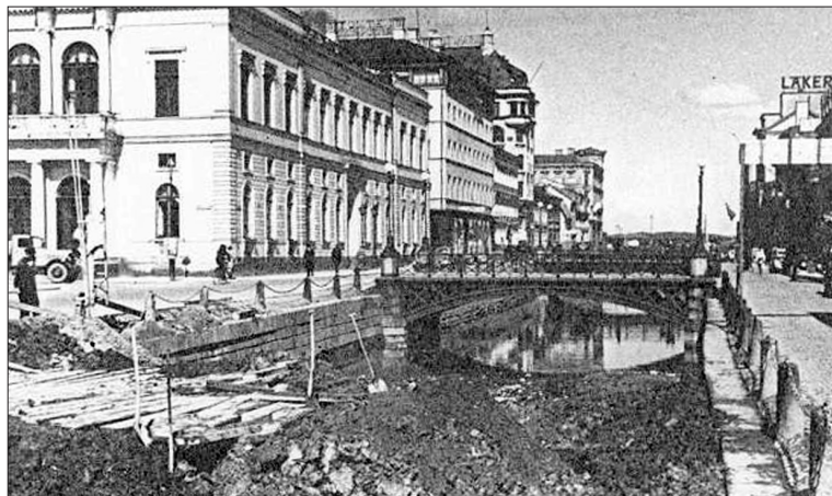
Figur 1. Igenfyllning av kanalen i Östra Hamngatan år 1936.
