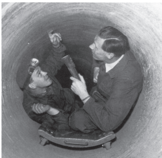
Vombledningen inspekterades i hela sin längd från insidan av Lennart Larsson (redaktörens far) och Sigvard Gudmundson. Extra beundransvärt av den senare som är i det närmaste 2 meter lång.
