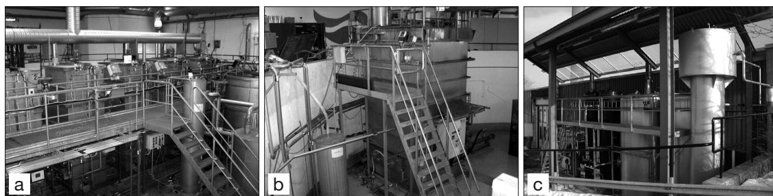
Figur 3. Pilotanläggning linjer Hammarby Sjöstadsverk, a) traditionell aktivslamprocess med sedimentering, b) membranbioreaktor (MBR) och c) anaeroba processer; UASB-reaktorer (Upstream Activated Sludge Blanket) och röt-kammare för slam.
