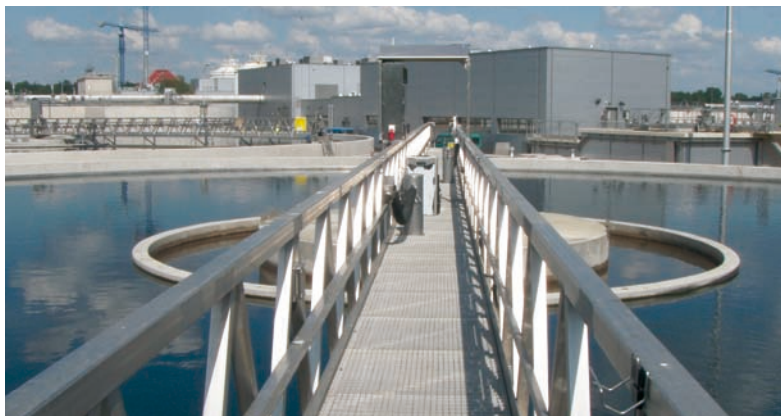
En av tre slamskrapor från Conpura som ska levereras till Gaza. Foto: Conpura.
