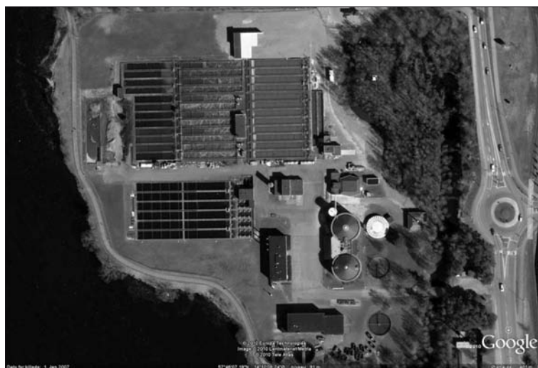
Figur 9. Simsholmens avloppsreningsverk, Jönköping.
