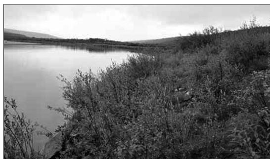
Figur 7. Samme erosjonssikringsanlegg som i Figur 6 fire år etter etablering av vegetasjon.
