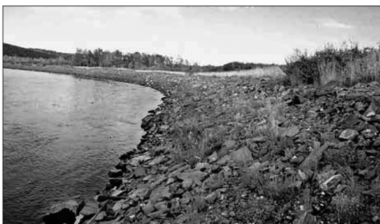
Figur 6. Erosjonssikringsanlegg for etablering av vegetasjon.
