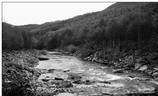
Figur 5. Parti av Bognelva etter fjerning av erosjonssikring og utlegging av denne i elva.
