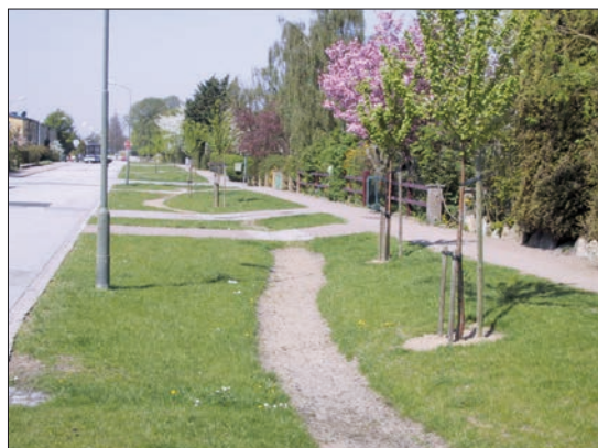
Figur 15. Svackdike i Vanäsgatan som avlastar det kombinerade avloppssystemet (foto: Peter Stahre).
