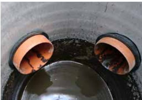
Figur 4. Fördelningsbrunn med ”hål” i botten. Bilden t.v. visar brunnen vid ankomst till anläggningen. Vattenytan ligger cirka 1 dm under utloppsroren. Bilden t.h. visar brunnen efter cirka 5 minuters flöde till anläggningen. Ytan har då stigit till utloppsroren.
