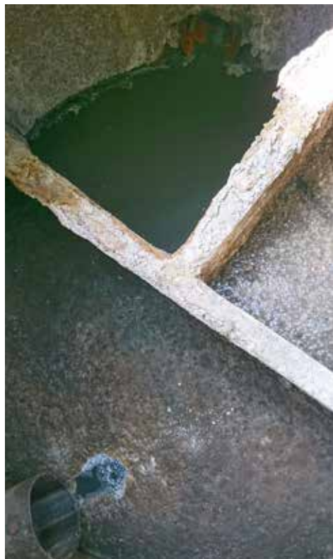
Figur 5. T.v. gammal slamavskiljare som saknar T-stycke. Slamavskiljare med trasig mellanvägg t.h.
