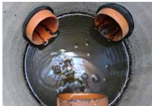
Figur 4. Fördelningsbrunn med ”hål” i botten. Bilden t.v. visar brunnen vid ankomst till anläggningen. Vattenytan ligger cirka 1 dm under utloppsroren. Bilden t.h. visar brunnen efter cirka 5 minuters flöde till anläggningen. Ytan har då stigit till utloppsroren.
