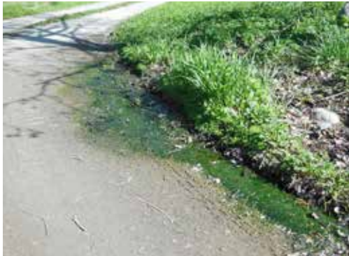
Figur 2. Vatten från infiltrationsbädd som läcker ut på väg. Bädden ligger 5 meter från väg.
