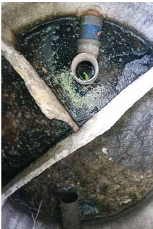
Figur 5. T.v. gammal slamavskiljare som saknar T-stycke. Slamavskiljare med trasig mellanvägg t.h.
