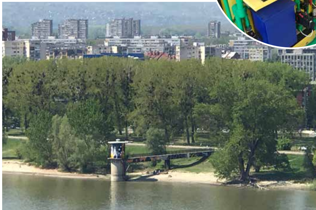
Figur 6. Utsikt över Novi Sad från Petrovaradin-fästningen. En av horisontalbrunnarna syns i bild.
