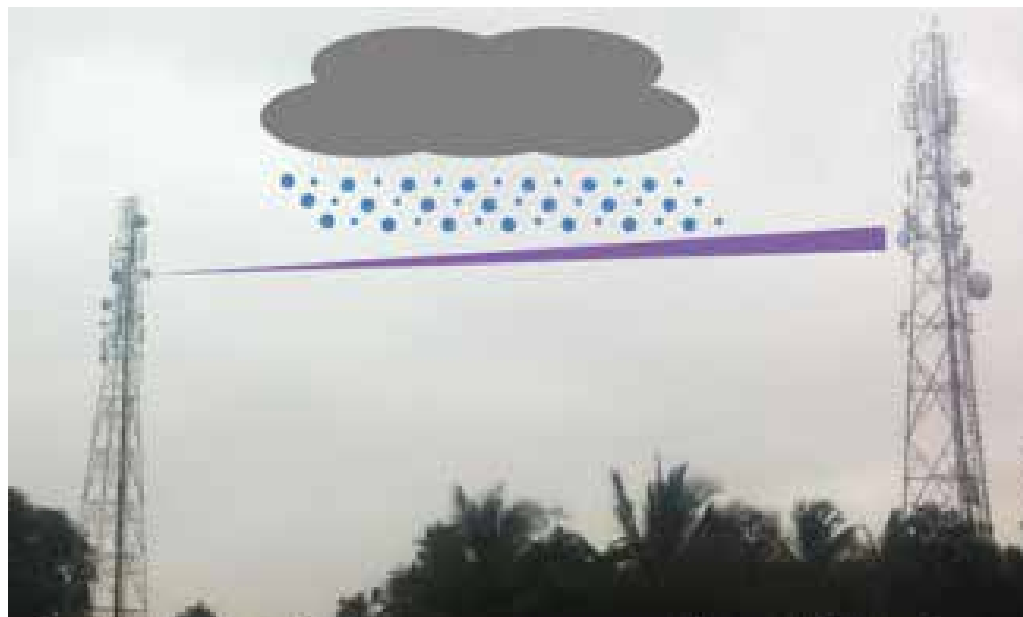
Figur 3. Två mobilmaster sammankopplade med hjälp av en mikrovågslänk. Länkens signalstyrka dämpas av regndroppar som faller mellan masterna. Foto Jafét Andersson.
