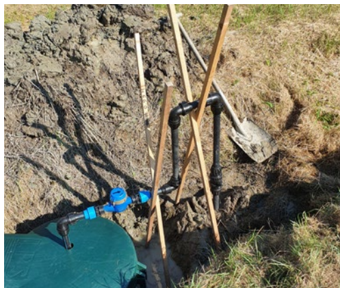
Figur 7. Pumpbrunn vid utloppet.
