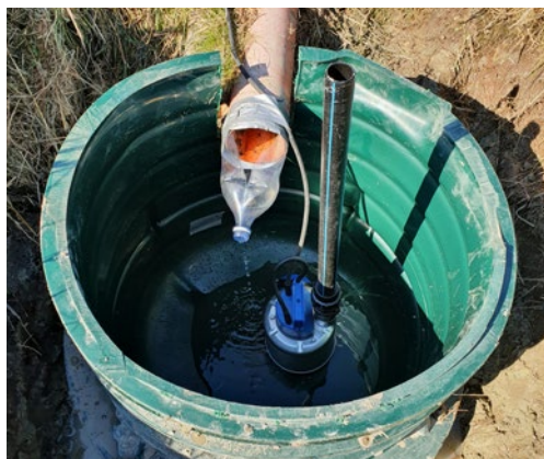
Figur 10. En väl rengjord PET-flaska får fungera som styrning vid änden på utloppsroret.
