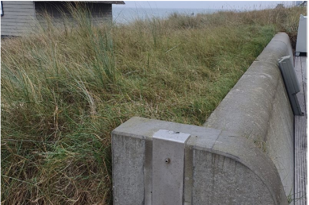
Kustskydd av betong integrerat i sanddynerna i Scharbeutz, Tyskland.
