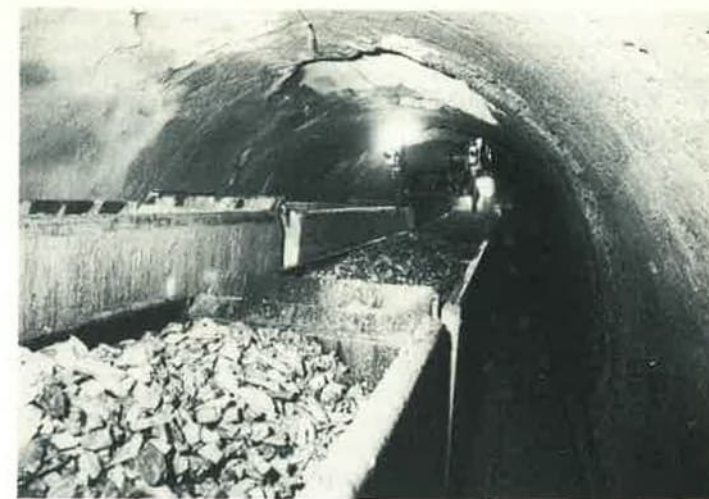
Figur 3. Borrregaget följs av vagnar för uppsamling och bortforsling av bormassorna.
