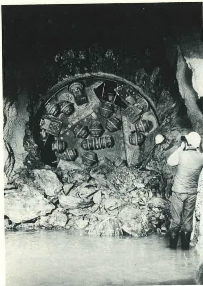
Figur 2. Ett fullortsborrningsaggregat har just nått fram till tunnelns ändpunkt.
