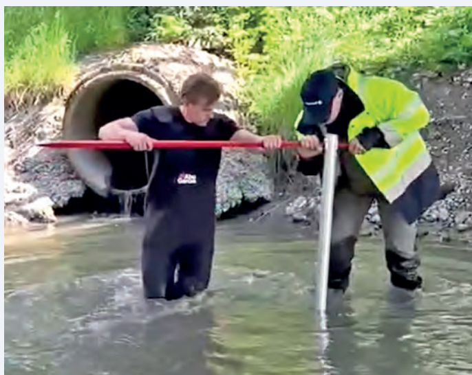
Installation av flödesmätare i Lillån.
