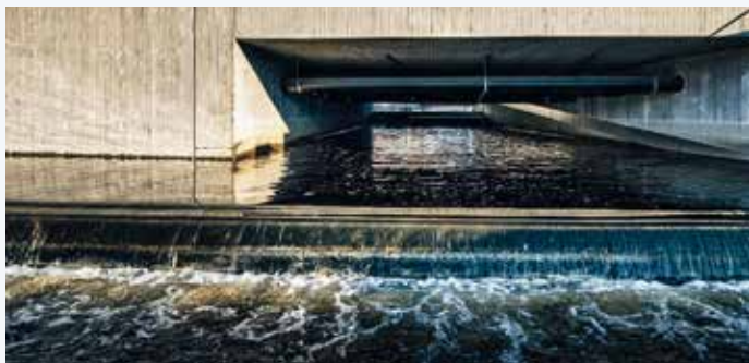
Här skimtar årännan som Mölnaldalsån rinner i genom hela Forsåker via det framtida Vattentorget. Här finns en älyngeledare inbyggd för att underlätta passagen och vattnet kraft nyttjas för energi.
