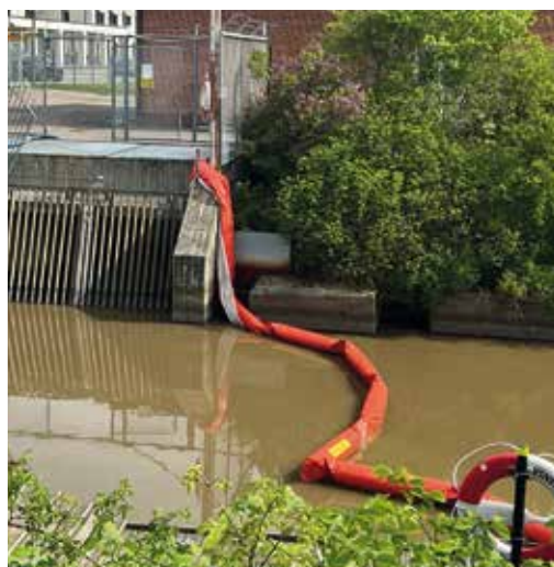
Läns som ligger utlagd i kanalen i Malmö för att fånga upp avloppsvatten. Foto: Oscar Kinrell, VASYD
