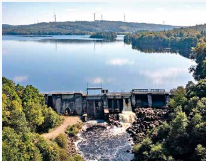
Åtraforsdammen i Åtran. En tidigare älvräcka har förvandlats till ett lugnflytande, sjölikt system. Samtidigt hindras fiskens vandring i vattendraget. Foto: Duncan Philpott
